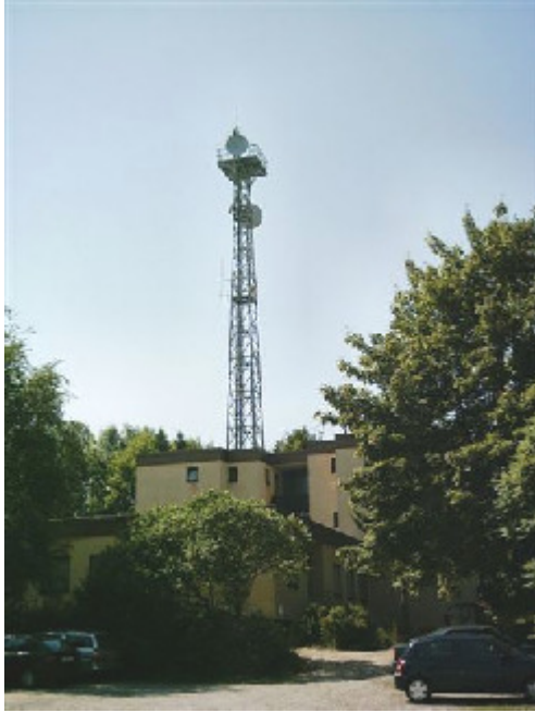
Funkmast zwischen Merkurstr. Höhe Hausnr. 31 und Am Zieget
