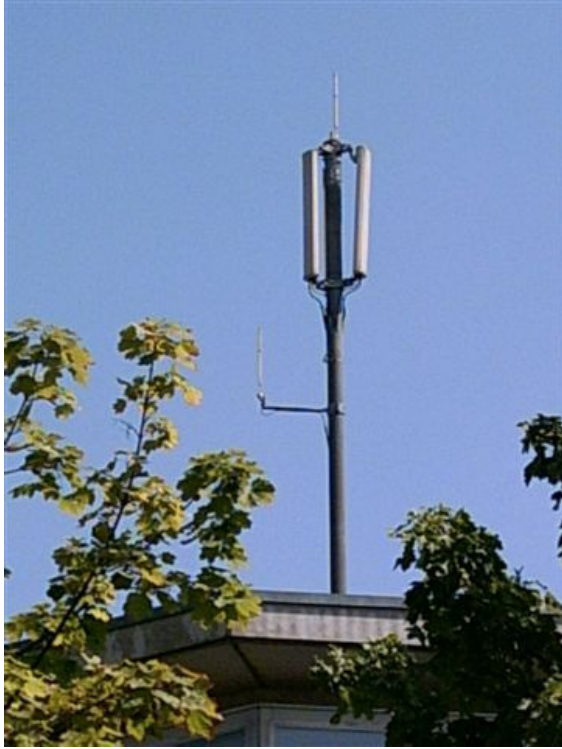
Protzenweiherbrücke, auf dem Schleusenturm
